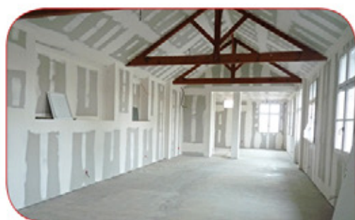
Travaux Intérieurs (novembre 2015)
