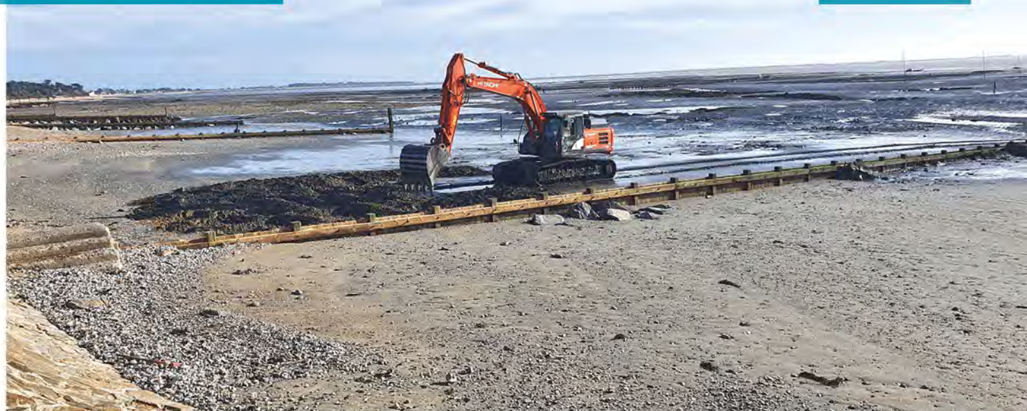
Remblaiement et renforcement des casiers
