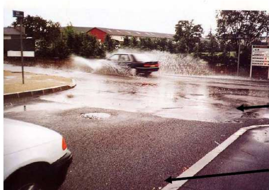
Chaussée à structure réservoir, Craponne (CERTU - 1994)
