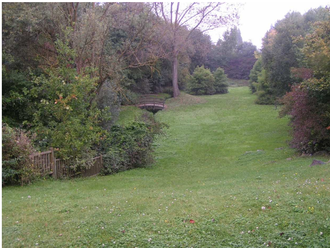
Photo 6 : Ouvrage double fonction : aire de promenade et bassin à sec
