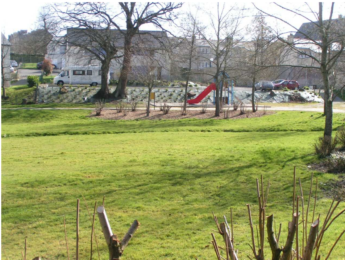
Photo 5 : Ouvrage double fonction : aire de jeu et bassin à sec
