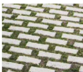
Pavage en béton avec ouvertures de drainage
