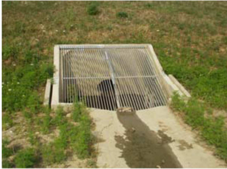
Grille de protection sur ouvrage de sortie
