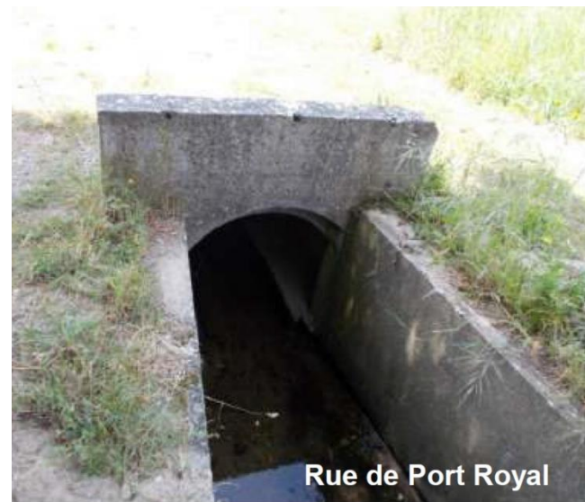
Remplacement de l'ouvrage de franchissement sous la rue du Port Royal
