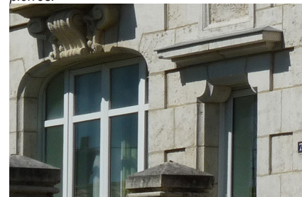
Parement en pierre de taille intégrant le décor de façade.
