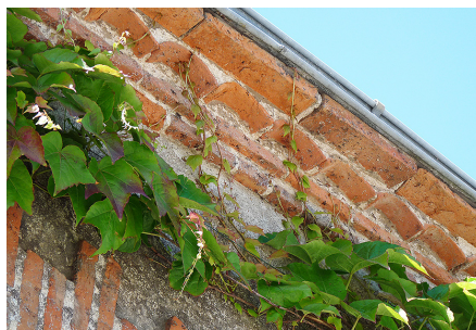
Génoise en tuileaux plats et morceaux de tuiles rondes, maison de bourg du début du XIX e .
