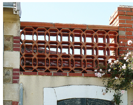
Garde-corps en brique et éléments de terre cuite moulée, début du XX e siècle.
