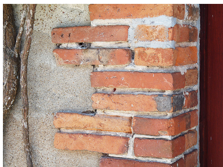
Encadrement en tuileaux de terre cuite artisanaux pour une maison du bourg du début du XIX e siècle.
