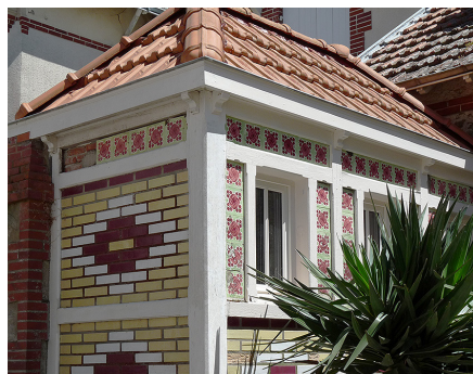
Construction en bois et brique avec revêtement en terre cuite émaillée, chalet balnéaire début XX e siècle.
