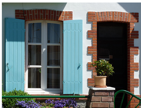
Encadrements classiques en briques 5x11x22 pour un chalet balnéaire des années 1900.
