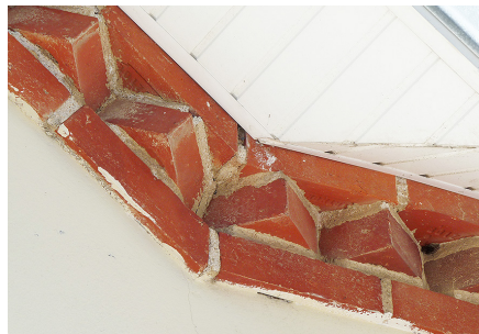
Corniche en briques industrielles posées droites et de biais, chalet balnéaire du début du XX e siècle.
