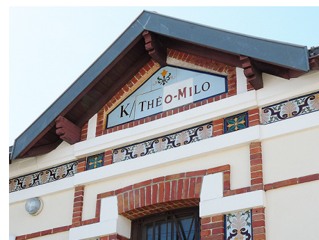
Décor composite mêlant brique, terre cuite émaillée et pierre sur une maison des débuts du XX e siècle.
