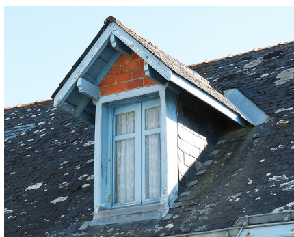
Lucarne gerbière en charpente et brique, intermédiaire entre un modèle rural et balnéaire.
