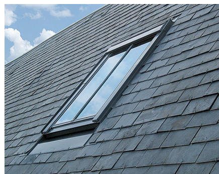
Châssis de toit encastré sur le modèle des anciennes tabatières (marque Velux).
