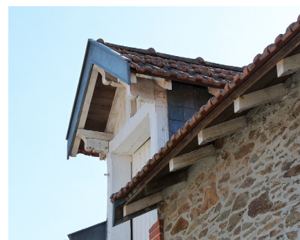
Demie-lucarne en charpente et jambages de brique, avec toiture débordante en tuiles mécaniques.
