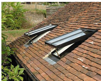
Châssis de toit encastré sur le modèle des anciennes tabatières (marque Cast-PMR).
