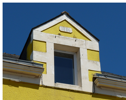
Lucarne en maçonnerie enduite et parements de pierre. L'enduit peint poursuit celui de la façade.
