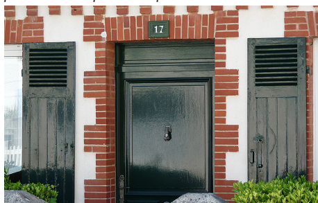
Porte à panneaux moulurés et volets partiellement persiennés d'un chalet balnéaire.
