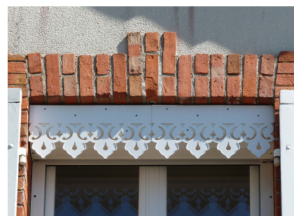
Un lambrequin de bois découpé peut camoufler le coffre d'un store à enroulement.
