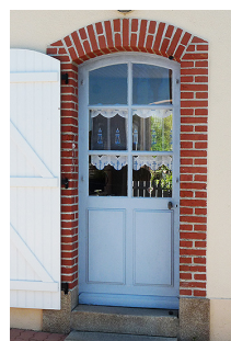
Porte vitrée adaptée à la courbure du linteau.
