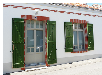
Porte-fenêtre et fenêtre au dessin inspiré des années trente. Volets à écharpes biaisées.
