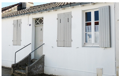
Élégante simplicité des menuiseries d'une maison de pêcheur. Porte pleine à imposte vitrée.
