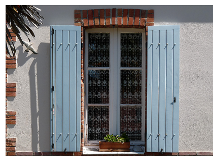
Fenêtre classique à trois carreaux et volets en planches verticales.
