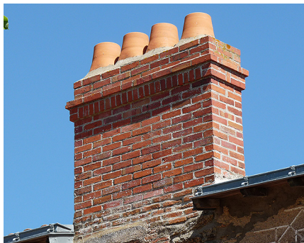
Souche restaurée avec joints et scellements au mortier de chaux.
