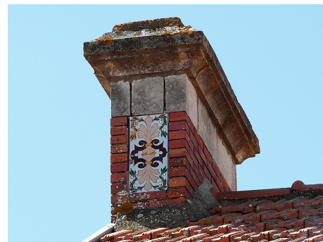
Souche en brique et pierre moulurée, avec carreaux émaillés prolongeant le décor d'une façade balnéaire.
