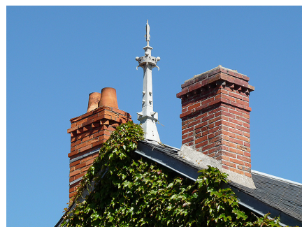
Souches à bandeaux et couronnement décoratifs avec briques posées en biais.
