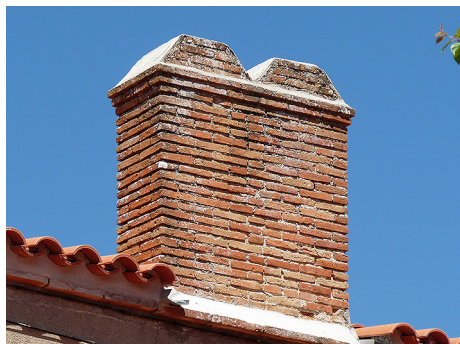
Souche ancienne en briques artisanales, à double couronnement pyramidal typique du pays de Retz.
