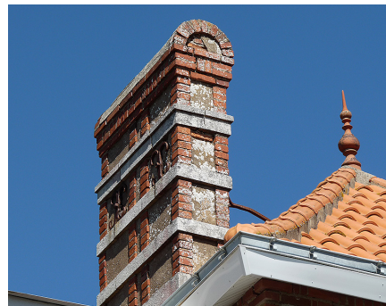
Souche en pierre, brique et moellons enduits. Sa restauration obéit aux mêmes règles que la maison.
