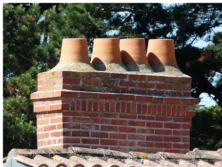
Souche classique en briques industrielles, à quatre pots de tirage scellés au mortier de chaux.
