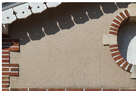
Enduit récent au ton de sable.
