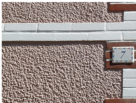
Sur un chalet de La Bernerie, enduit ancien dit « tyrolien », c'est-à-dire appliqué à l'aide d'un outil mécanique (tyrolienne) créant des rugosités en vogue à la fin du XIX e siècle et dans les débuts du XX e .
