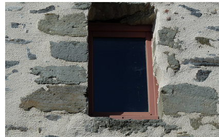
Enduit neuf « à pierres vues », réalisable sur des murs de clôture ou des bâtiments du monde rural.
