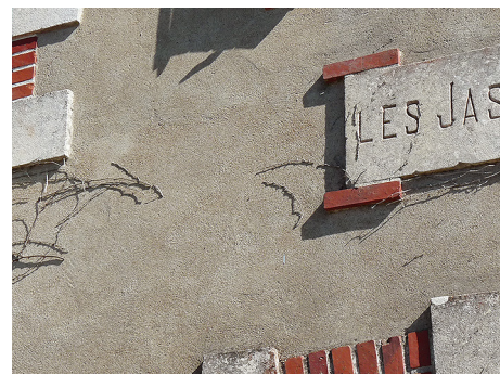
Bel enduit ancien lissé au ton de sable, dont le retrait met en valeur les éléments de pierre et de brique constituant la modénature de la façade.
