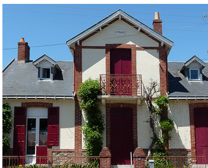
Couverture en ardoise pour une toiture de villa avec lucarnes en bois.
