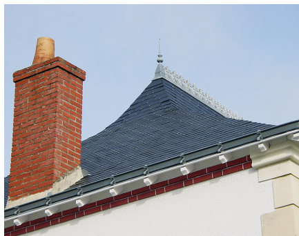
Couverture refaite en ardoise, avec solin de cheminée à la chaux, épis et faîtage décoratif en zinc.
