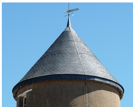
Couverture d'ardoise à pose décorative et girouette en zinc pour la toiture en poivrière d'un moulin à vent.
