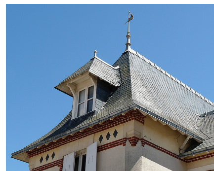
Haute toiture à débords et brisures de bas de pentes pour une importante villa. Girouette en zinc.
