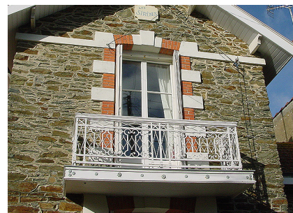
Balcon et garde-corps métalliques, formant un élément majeur de la composition de la façade.
