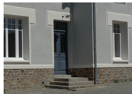
Mise en valeur d'une façade des années trente avec un enduit peint en gris pâle, des encadrements blancs, un soubassement en pierre, une porte gris bleu.
