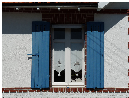
Teintes courantes des maisons de bourg et des chalets du XIX e siècle, avec enduit ton sable ou chaulé en blanc, encadrements en brique et volets colorés.
