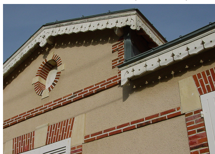
Harmonie de type traditionnel à La Bernerie avec enduit ton sable, pierre et brique naturelles, menuiseries et lambrequins en bois peint en blanc.
