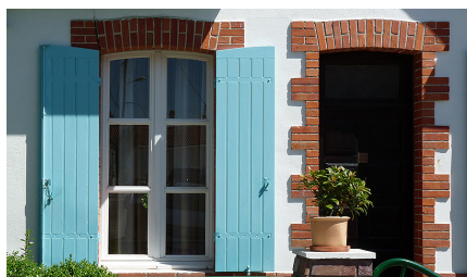
Volets bleu clair, fenêtre blanche et porte sombre sur une façade blanche à encadrements de brique.
