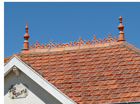
Couverture en tuiles mécaniques avec faitage et épis décoratifs en terre cuite. Ces tuiles permettent de couvrir des pentes plus fortes que la tuile ronde.
