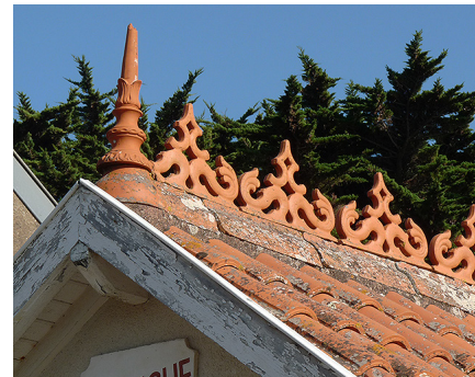
Faîtage décoratif et épi ouvragé en terre cuite.
