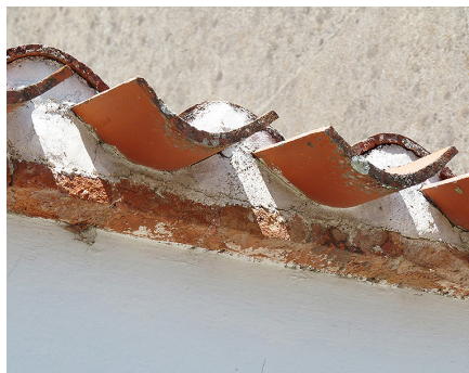
Egoût à l'ancienne sans gouttière, avec tuiles en débord, supporté par un rang de tuileaux (ancêtre de la génoise).
