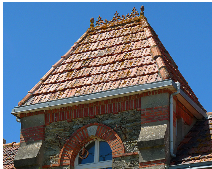
Couverture en tuiles mécanique de forte pente.
