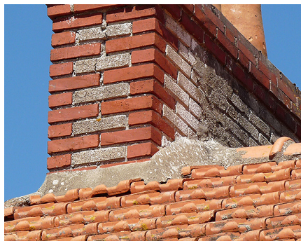
Solin de cheminée en mortier de chaux et de sable.
