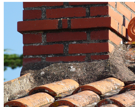
Solin de cheminée réalisé au mortier de chaux et de sable.
