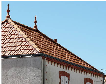
Couverture en tuiles mécaniques avec tuiles de recouvrement décoratives.
