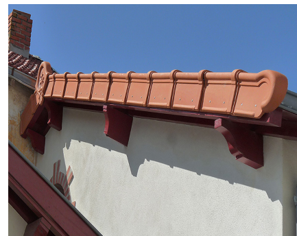
Rive en tuiles décoratives vissées dans le chevron.
