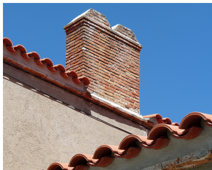
Egoût sans gouttière, réalisé avec des tuiles mécaniques simulant les tuiles rondes.
