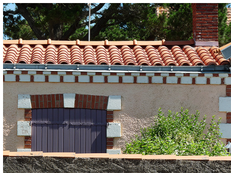
Couverture en tuiles modernes simulant la tuile ronde (chaque tuile associe une partie supérieure et une partie inférieure) avec faitage à emboîtements et gouttière en zinc.
