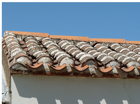
Couverture en tuiles rondes posées à l'ancienne, avec scellement des tuiles au mortier de chaux, faitage sans emboîtements, et égoût de toiture avec simple débord du dernier rang des tuiles de dessous..
