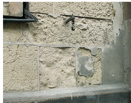
Dégradation d'un mur : l'humidité ressort au dessus d'un soubassement cimenté.
