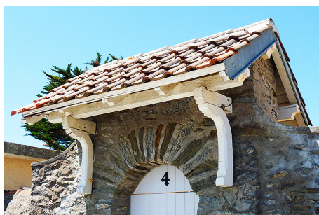
Un auvent décoratif en charpente monumentalise une porte aménagée dans une clôture en pierre.
