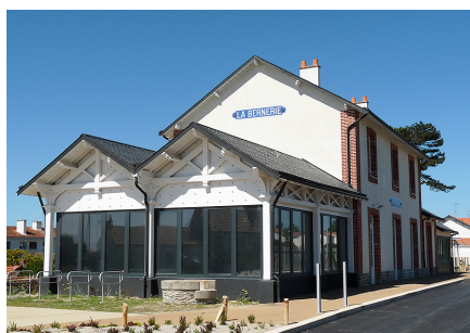
La gare de La Bernerie elle-même s'orne de charpentes décoratives, dans l'esprit à la fois industriel et balnéaire.
