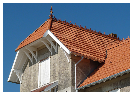
Les débords de la toiture sont l'occasion d'un travail de charpenterie décorative des débuts du XX e siècle.
