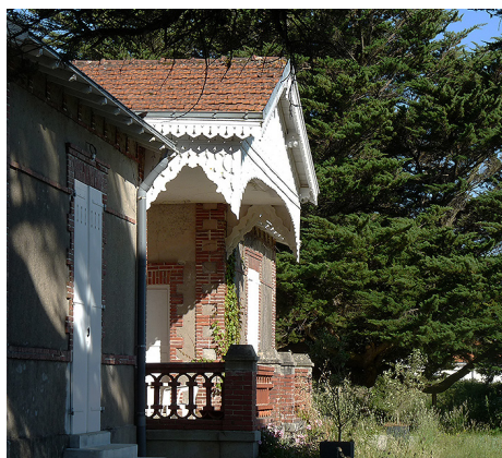
L'auvent surmontant un retrait de façade crée un espace extérieur abrité et dynamise l'architecture de cette villa. Ses lambrequins de bois découpé répondent aux garde-corps en terre cuite de la terrasse.
