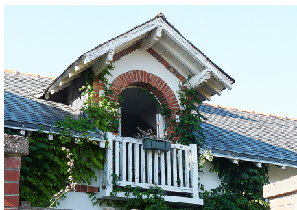
La toiture débordante d'une lucarne et son balcon composent un petit espace extérieur.
