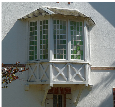
Le « bow-window » est un élément issu de l'architecture gothique anglaise. Il crée un espace lumineux, permet des vues latérales et anime ici un pignon de villa.
