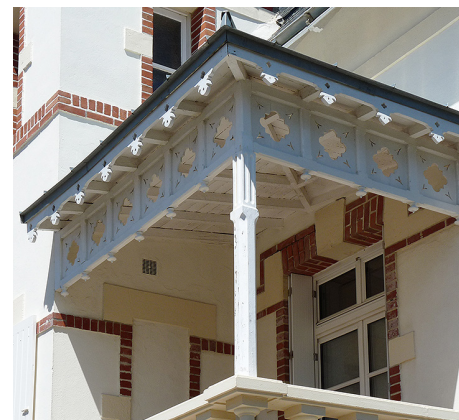
Un auvent en charpente surmonte ici une terrasse à l'étage. Les retombées en panneaux de bois ajourés complètent le garde-corps à balustres pour créer un véritable espace extérieur.
