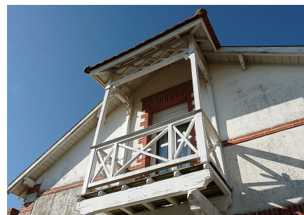
Balcon en bois dont le garde-corps se poursuit par une ossature portant la charpente d'un auvent.
