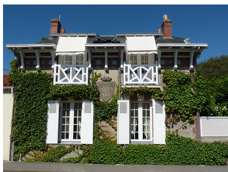
Villa balnéaire « Génovéfa » (1883) avec décors en pierre, brique, zinc et charpentes peintes.
