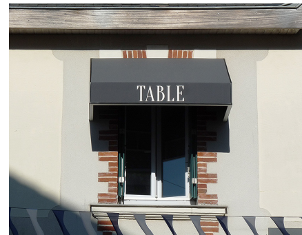
Le surdimensionnement d'un store fixe peut détruire la lisibilité d'une architecture.
