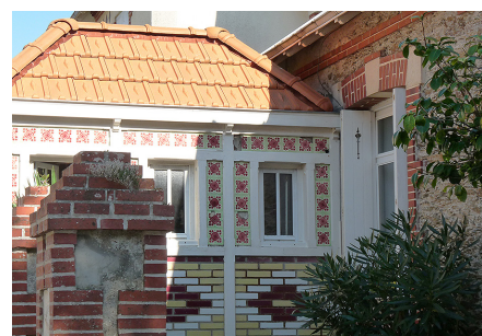
Petite extension ancienne devant un chalet, qui doit sa qualité à son ossature de bois peint, à son décor de terre cuite émaillée, à sa toiture en pavillon.
