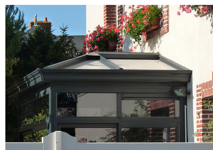
Véranda métallique en adjonction d'une maison ancienne. Le gris sombre allège ici l'impact visuel de son ossature.
