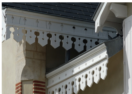
Alliance de formes et de matériaux d'une architecture balnéaire de la fin du XIX e siècle : pierre, enduit, brique, bois peint, ardoise, zinc.
