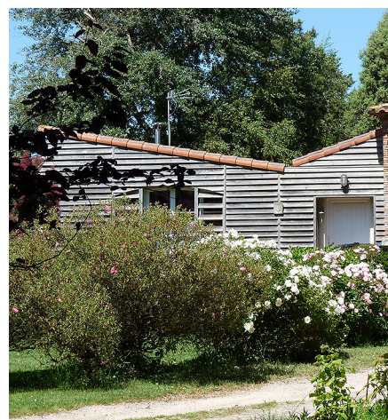
Les arbres et arbustes intègrent une extension contemporaine bardée de bois naturel dans son site rural.
