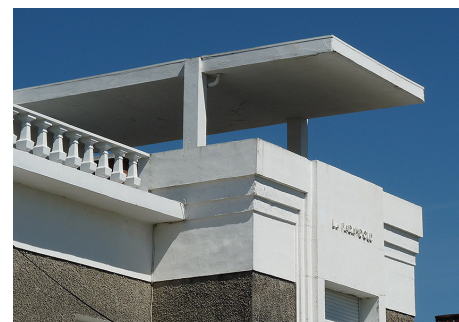
Grâce au béton et à la simplification des décors, les années 30 donnent une forme moderne aux espaces « d'entre-deux » de l'architecture balnéaire.
