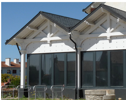
Une menuiserie contemporaine peut redessiner l'espace d'une ossature ancienne préservée, comme à la gare de La Bernerie-en-Retz.
