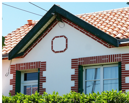
L'élargissement, même faible, d'une baie, peut rompre l'harmonie d'une façade symétrique dont l'axe est marqué par un pignon central.
