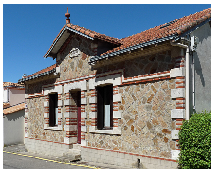
Cette façade au décor très ostensible et à la symétrie marquée ne supporterait pas de modification de ses percements.
