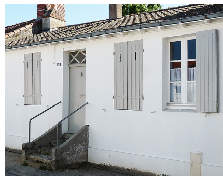
L'ajout d'une nouvelle fenêtre identique à celles existantes, comme celle de droite, est préférable à l'élargissement de l'une d'elles.
