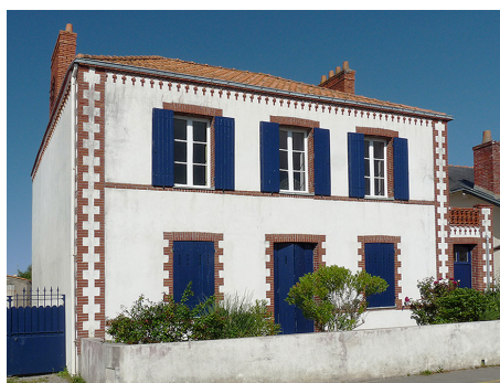
Villa classique à la façade « réglée » selon deux niveaux horizontaux et trois axes verticaux (trois « travées »). La porte d'entrée est dans l'axe médian. Un bandeau de brique souligne la hauteur des appuis de l'étage.
